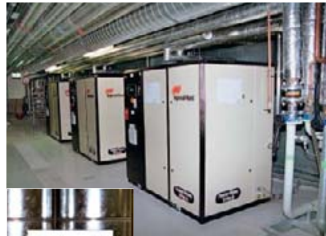
Im Zentrum der Druckluftstation: Drei energiesparende, drehzahlregulierte Nirvana-Verdichter
